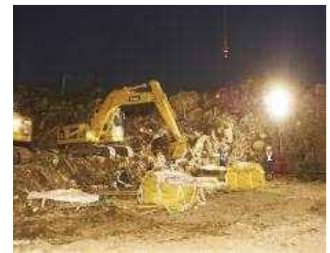
2011.12 夜間作業の様子 (宮城県石巻市)
