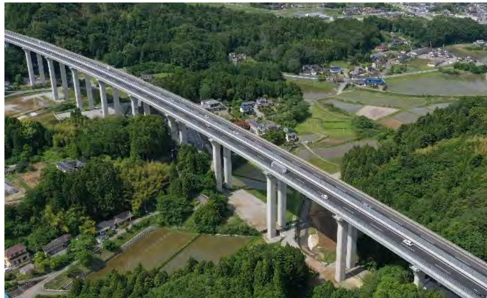
常磐自動車道(いわき中央IC~広野IC) R3.6.13 4車線運用開始
