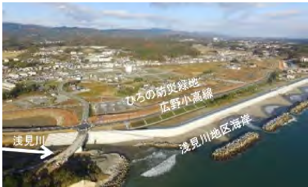
海岸堤防、防災緑地、道路の復旧・整備 (広野町)
