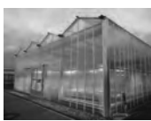
(スマート農業対応温室)
